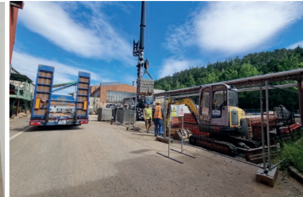
Výstavba nové kotelny.
