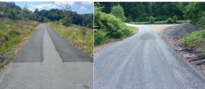
Oprava cest Rosošné a Švajgrovka, Chvalčov. Foto: Ing. Pavel Bednář.
