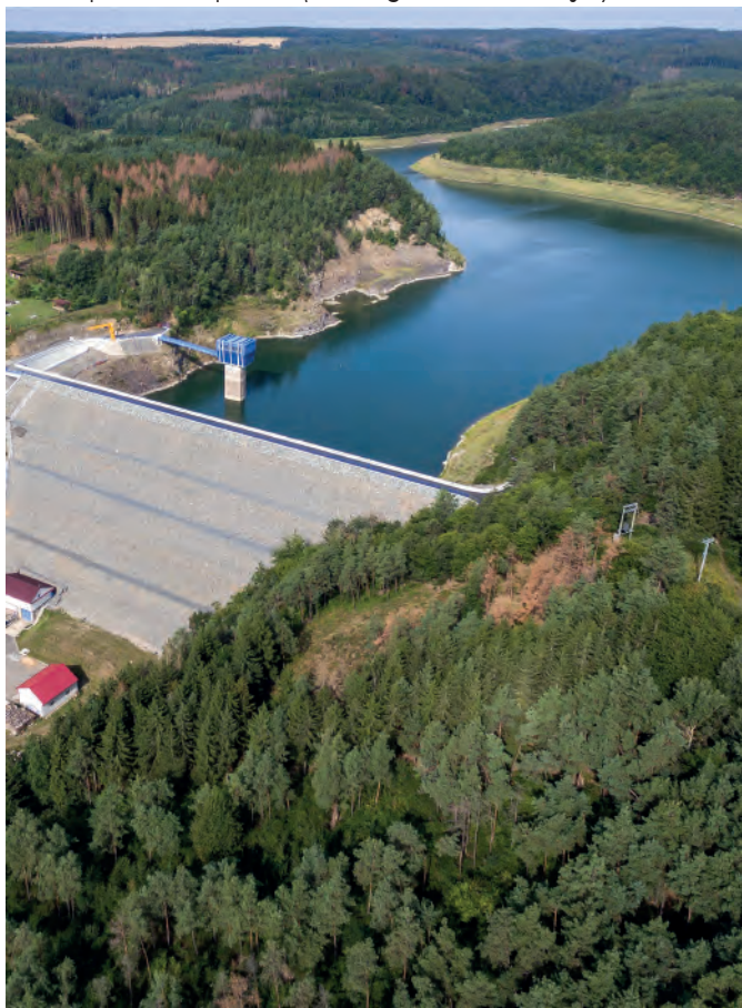
Nová hráz, Vodní nádrž Opatovice, r. 2020. Foto: Ing. Miroslav Foltýn.
