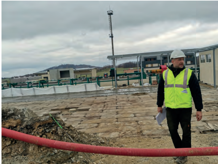
Ing. Martin Sadílek při stavebním dozoru na vznikajícím pilařském závodě
