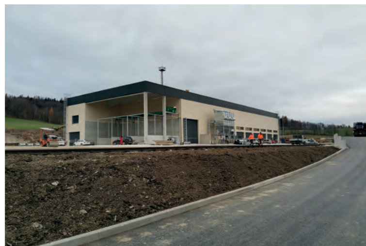
Hlavní výrobní hala, pohled směrem od budovy polesí
