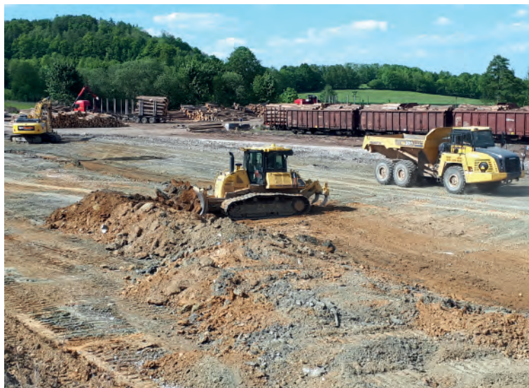
Úprava zpevněných ploch, pohled od hlavní haly Foto: Ing. Martin Sadílek
